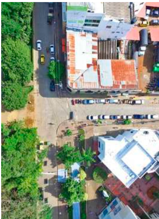
Antes y después de la intervención.
