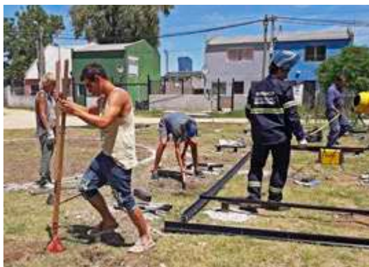
La comunidad construyendo su plaza.
