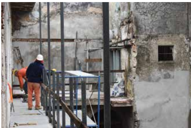
Obras en finca ubicada en Agraciada y Santa Fe destinada al primer centro de estadía transitoria, 2019.
